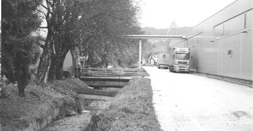
Durch den Ausbau des Gießenbaches wird die Gefahr für die Unternehmen dort gebannt. Dazu wird der Bachverlauf im Bereich der Brauerei verändert, zahlreiche Querungen werden entfernt.
