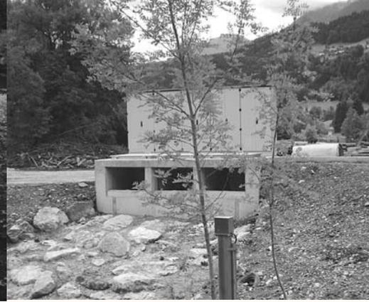
Die Mündungssituation des Blödlebaches wurde verbessert. Das Pumpwerk im Bereich des Holzlagerplatzes dient der Hinterlandentwässerung. Kosten: 200.000 Euro.
