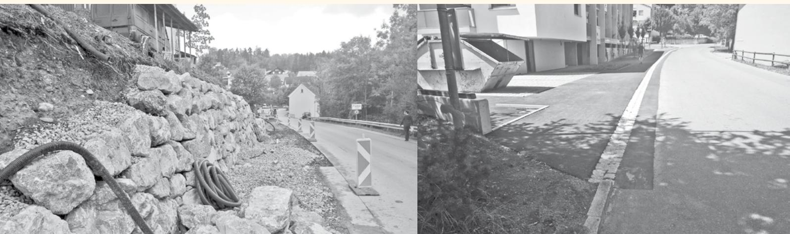
Durch den neuen Geh- und Radweg hat sich die Situation in der Felsenau deutlich entschärft. Die Böschung musste mit einer bis zu 2,75 Meter hohen Steinschichtung gesichert werden.
