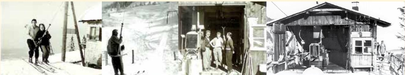
Der Schlepplift wurde 1953 gebaut. Die komplett aus Holz gefertigten Masten mussten Anfang der 60er-Jahre durch teergetränkte Masten, die mit Beton im Boden verankert wurden, ersetzt werden.
