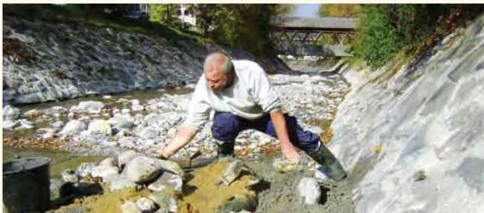
An den Schwellenrändern muss regelmäßig neu betoniert werden.
