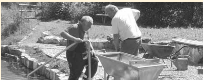
Für die Wassertrete hat das Bauhof-Team letztes Frühjahr einen Brunnen geschlagen.
