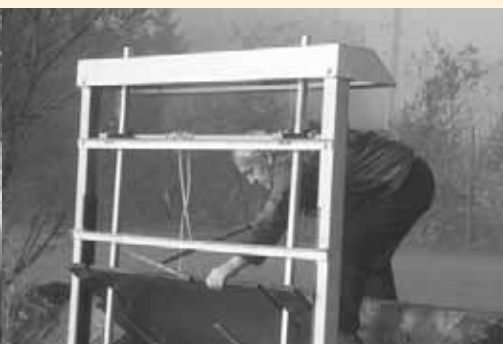
Mit diesen Schleusen wird der Wasserstand gesteuert.
