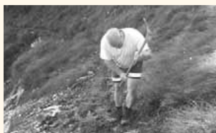
Mit der Haue repariert Thomas Riedmann den Wanderweg.
